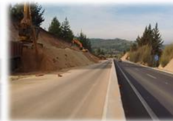
Excavación en Corte Obra Adicional Tercer Carril Cuesta El Litre, Dm 27.000, Sector A
