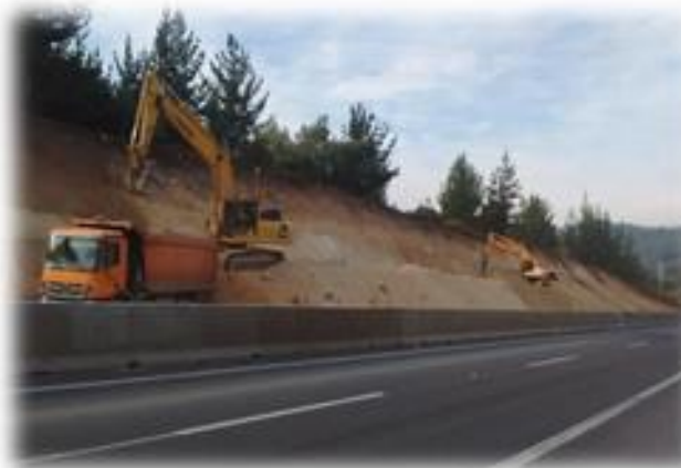
Excavación en Corte Obra Adicional Tercer Carril Cuesta El Litre, Dm 27.000, Sector A
