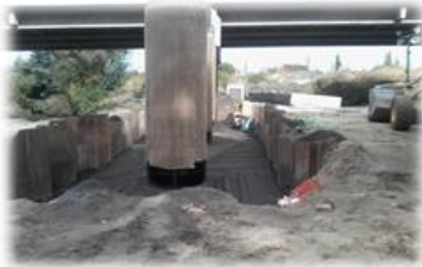
Ejecución de Cepas Punte Ibáñez Norte, Dm 14.100, Sector A
